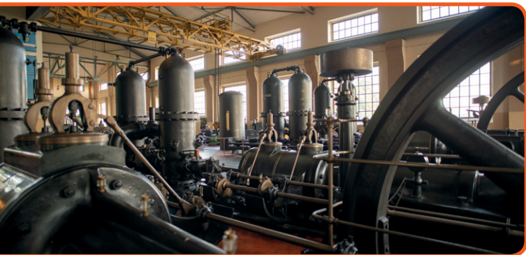
Stacja wodociągowa „ZAWADA”
