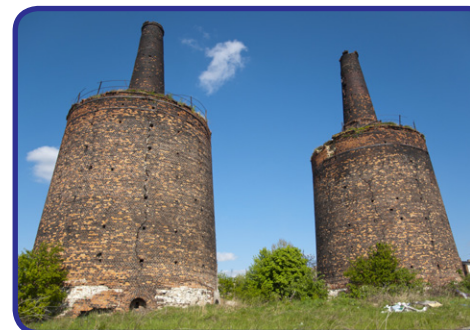
Piec wapienne, fot. P. Kras
