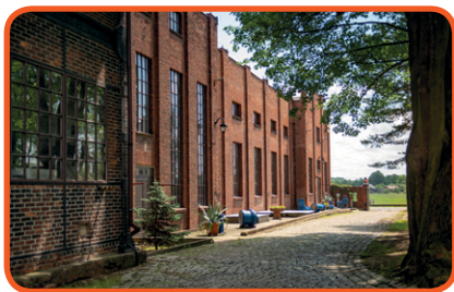
Stacja wodociągowa „ZAWADA”
