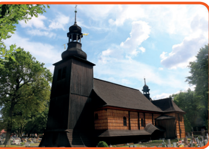
Kościół pw. Św. Trójcy w Koszęcinie
